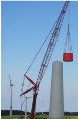
*Figura 54. Torre de hormigón.*
