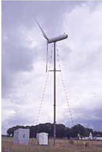
*Figura 52. Torre con tensores.*
