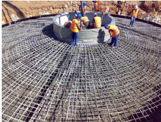
*Figura 56. Estructura de zapata circular.*
