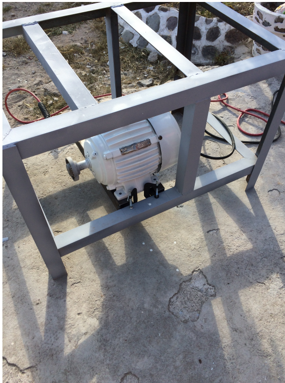
Figura 5.13: Montaje del motor sobre la base.
