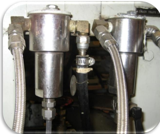
Figura A1.6 Diseño y orientación de la línea del sistema de escape para medir la presión de los gases y emisiones
