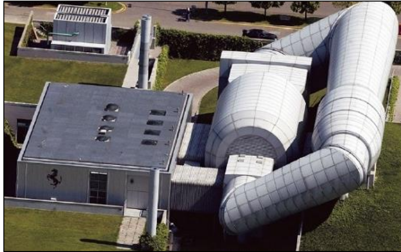
Figura 14. Túnel aerodinámico de circuito Cerrado. Maranello Italia.
