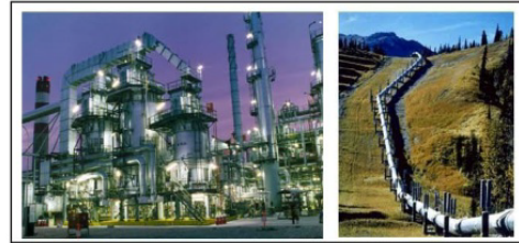
Figura 2. Sistemas de tuberías utilizados para transporte de fluidos a alta presión.
