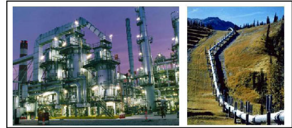
Figura 2. Sistemas de tuberías utilizados para transporte de fluidos a alta presión.
