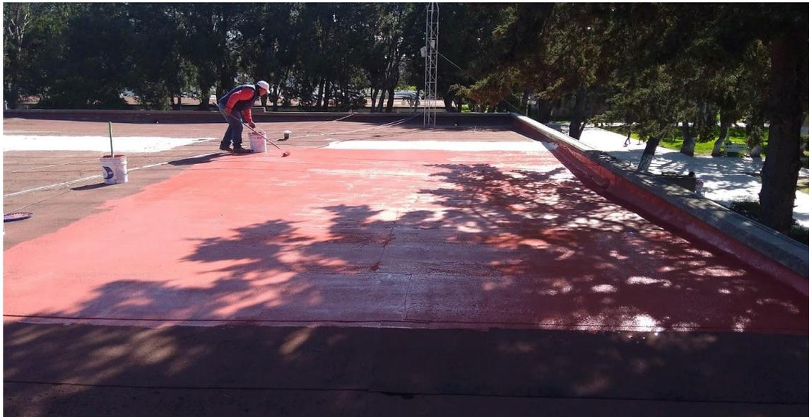
**Figura 43.** Impermeabilización del Centro de Información parte sur.
