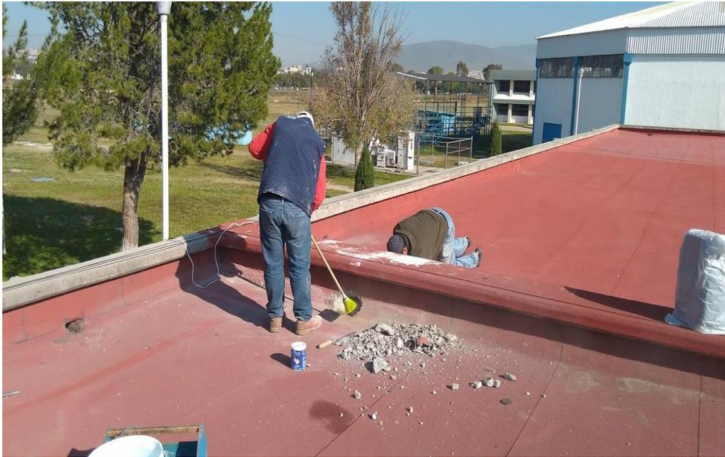
**Figura 42.** Impermeabilización del Centro de Información parte norte.
