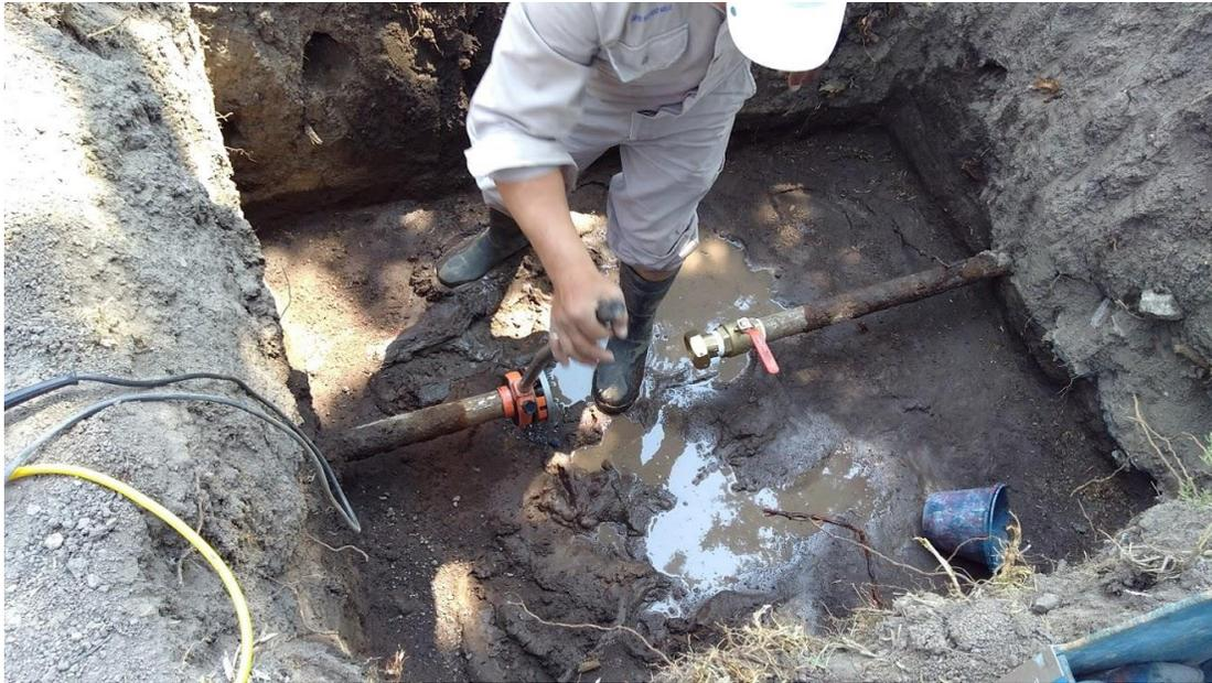
**Figura 46.** Mantenimiento a medidor de agua.
