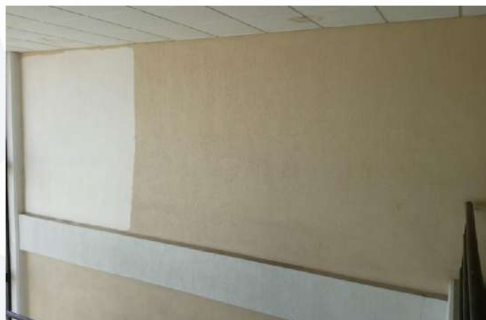
Imagen 105 – Muros internos del edificio B.
