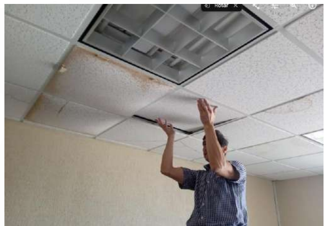
Imagen 97 – Reemplazo de plafones dañados.
