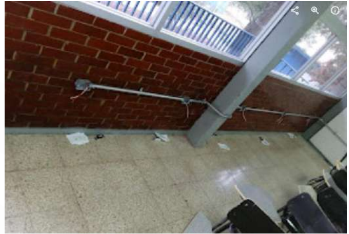
Imagen 93 – Instalación de contactos.
