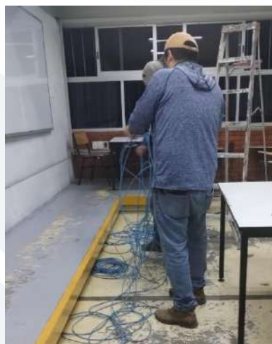
Imagen 109- Canalización de la red de datos
