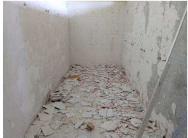
Imagen 107 – Rehabilitación de baños y regaderas del Gimnasio Olímpico.
