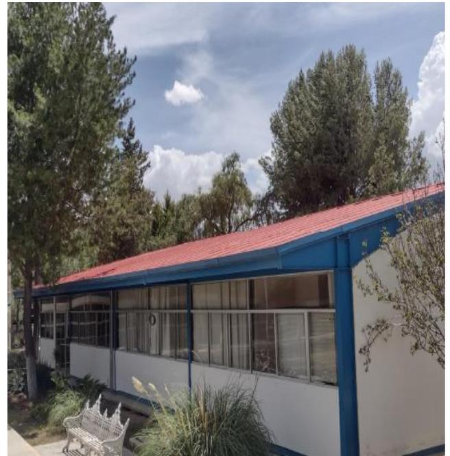
Limpieza de la superficie del todo el techo, retiro de material en mal estado y se aplicó impermeabilizante de 6 años color terracota blanco o similar, en la azotea del Edificio CT (Departamento de Ciencias de la Tierra) de una superficie de 369.6 m<sup>2</sup>.
