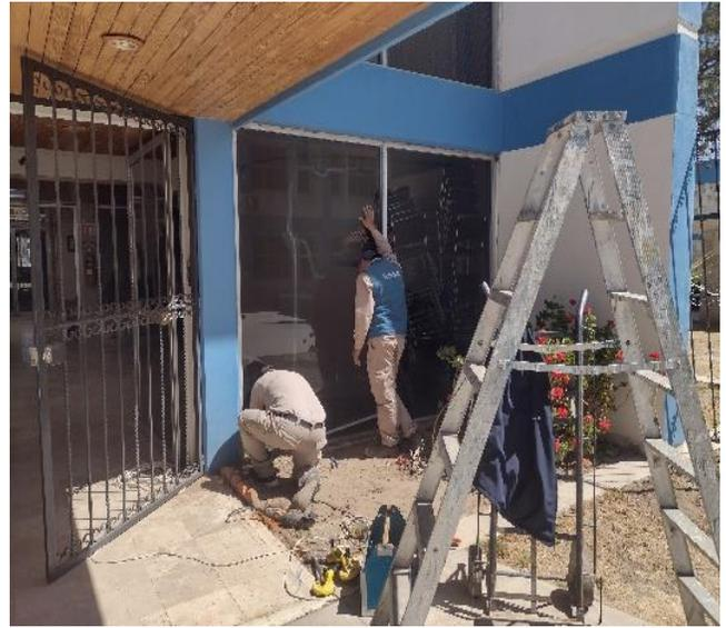
Se rehabilito la cancelería del Laboratorio de Electrónica y del Centro de Cómputo, cambiando los vidrios rotos de los accesos a los edificios.
