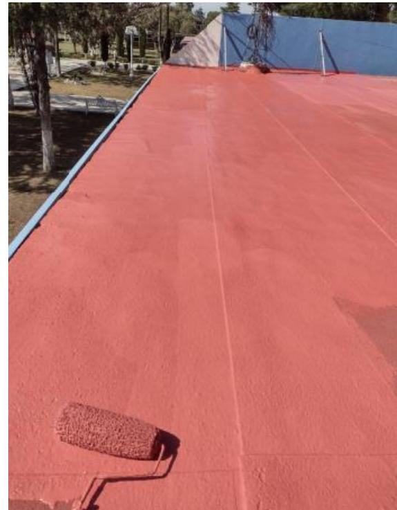
Se realizo la colocación Impermeabilizante de 6 años color terracota, en la azotea del Edificio Z de una superficie de 369.6 m2, incluye, limpieza de la azotea, aplicación a dos manos, sellado de uniones.
