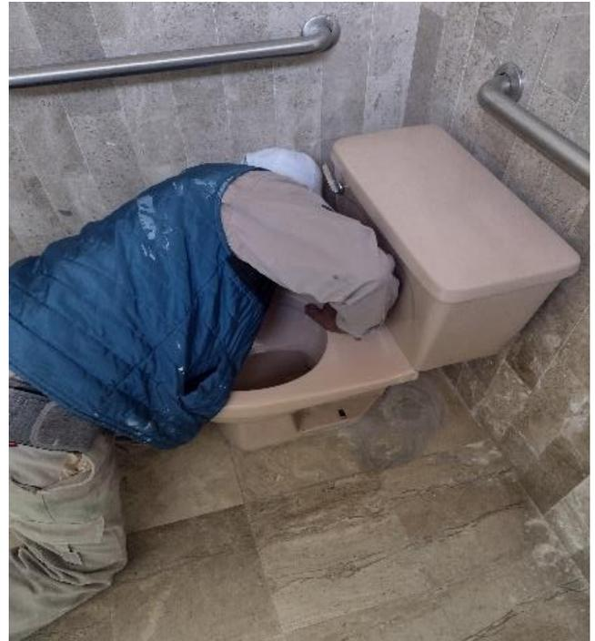
Se rehabilitaron los baños del Laboratorio de Topografía, Centro de Cómputo y edificio K, mediante el reemplazo de las tazas de WC.
