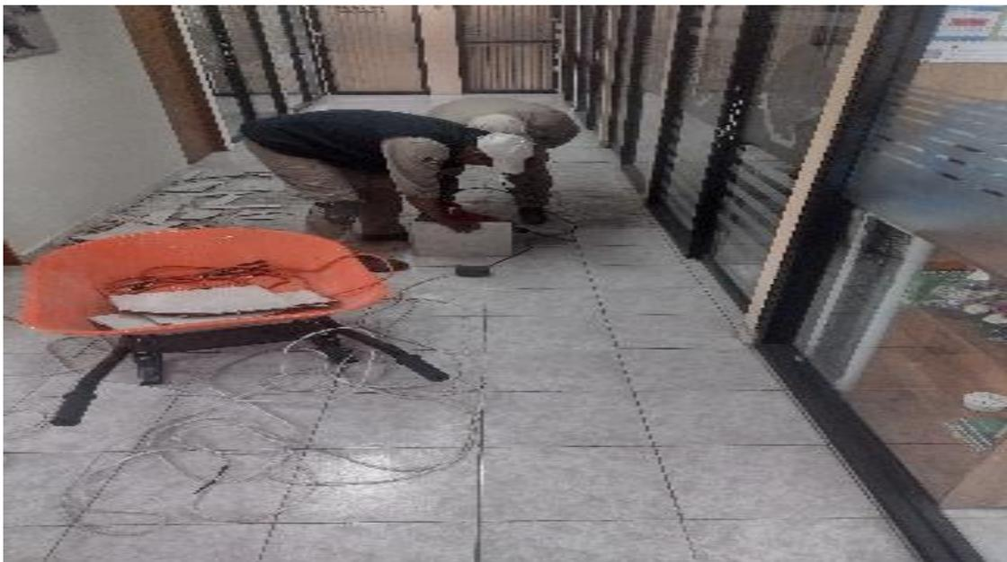
Rehabilitación 70 m2 de piso, nivelando la loza de concreto y colocando loseta.
