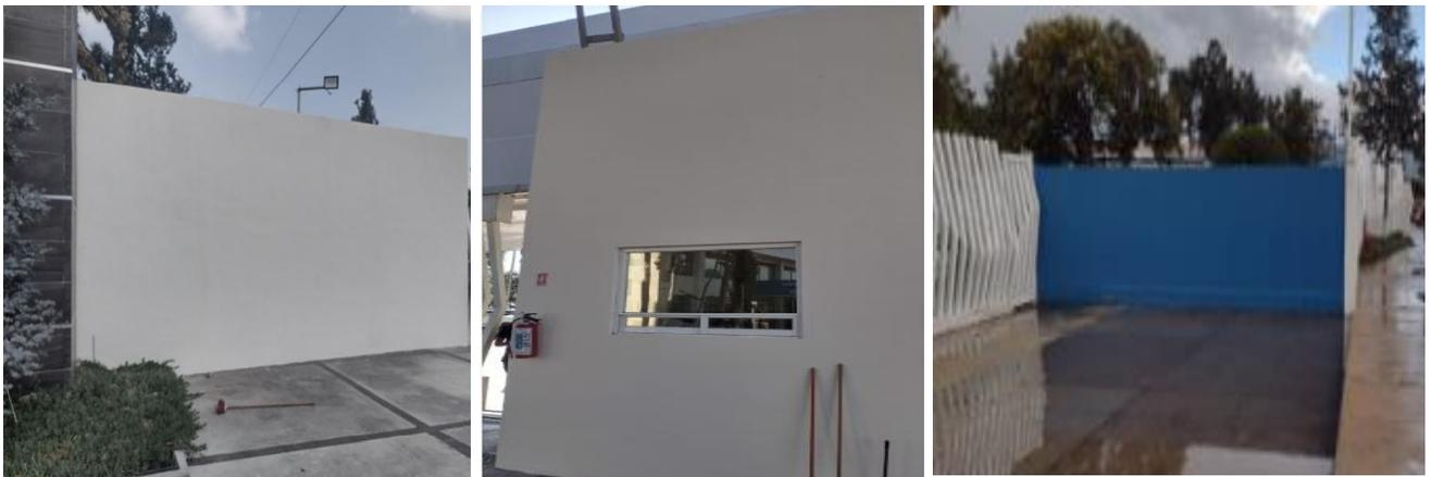
Se aplicó pintura vinílica color arena mediterráneo. Azul ITP y resane a muros externos e internos de la fachada principal.
