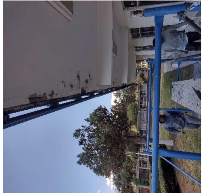
Se rehabilitó el exterior del edificio L del Departamento de Ciencias Básicas, resanando muros, aplicando pintura blanca y barniz a muros de ladrillo rojo.
