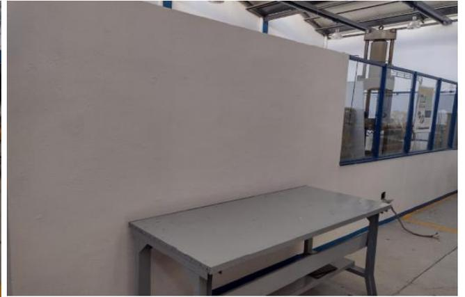
Se retiró la pintura en mal estado, se resanará las partes dañadas con estuco, finalmente se aplicó pintura a dos manos en una superficie de 220 m<sup>2</sup> de muros interiores. Se aplicó pintura vinílica color blanco y pintura vinílica color azul ITP en columnas, en planta baja.
