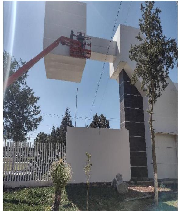
Se rehabilitó la estructura de la fachada principal del Tecnológico, mediante el reemplazo de las juntas de uniones de toda la estructura, así mismo, la limpieza profunda de toda la estructura.
