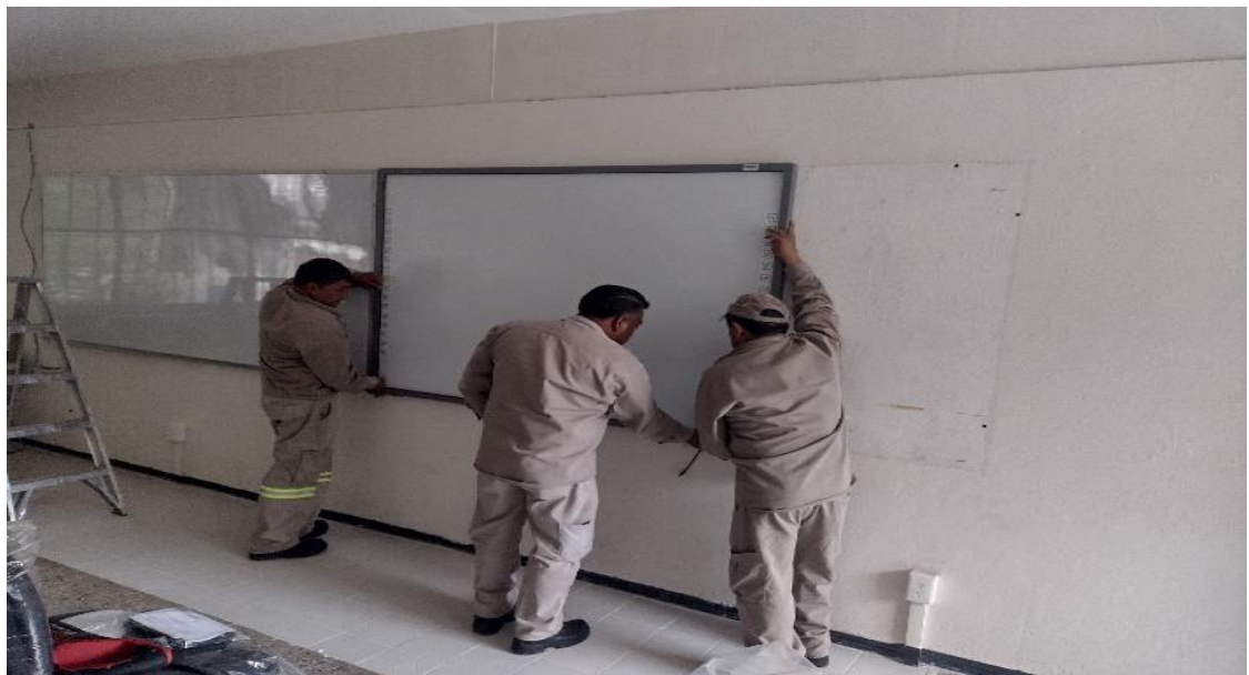
Instalación de pizarrones electrónicos, internet, cámaras, proyectores y pintura de muros.
