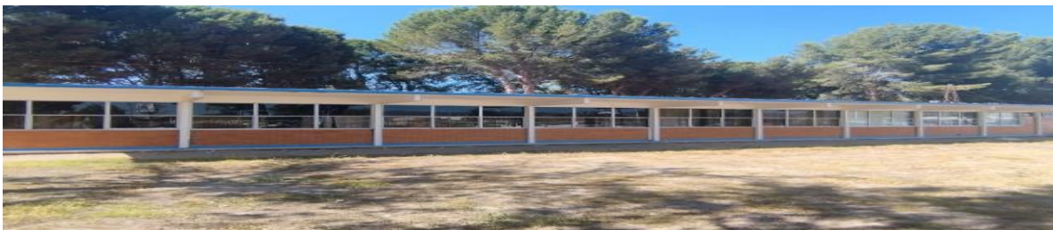
Aulas Z1 y Z2 del edificio Z
