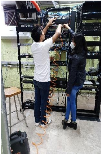
limpieza de Racks y vidrios, sopletear y peinar cableado
