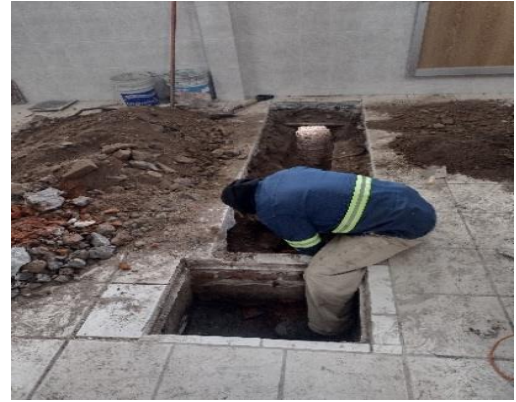
Desazolve y drenado de ductos de drenaje
