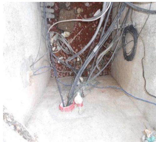
Cableado que se Retiro de los Registros
