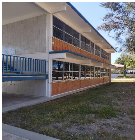
aula "G4" del edificio "G"
