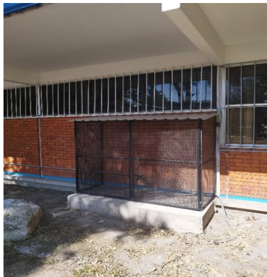
Aulas "J2" y "J3" del Edificio J
