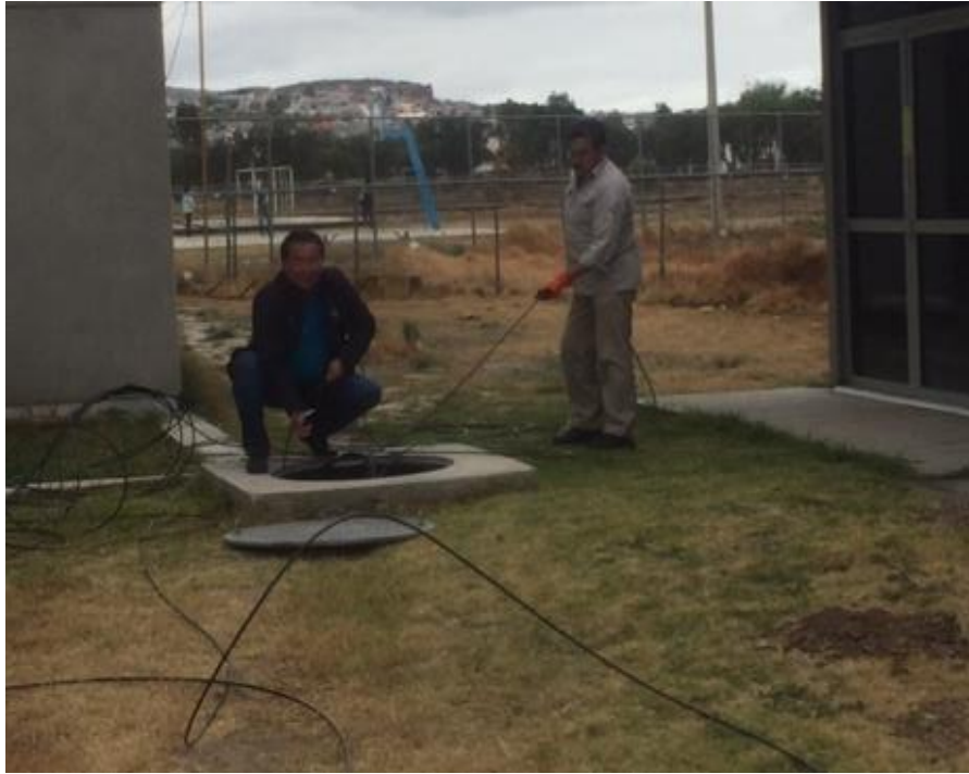
Figura 25. Tirada de acometida de fibra óptica.
